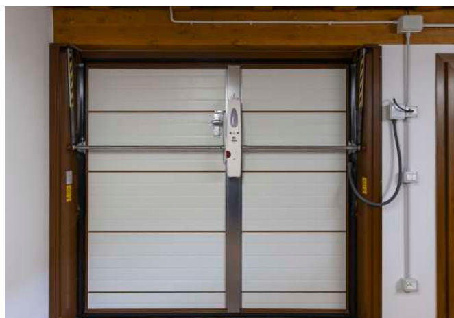
Motorizzazione ad un motore.
